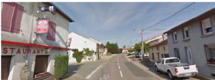
Photo du bourg de Vatimont avant l'enfouissement des lignes
